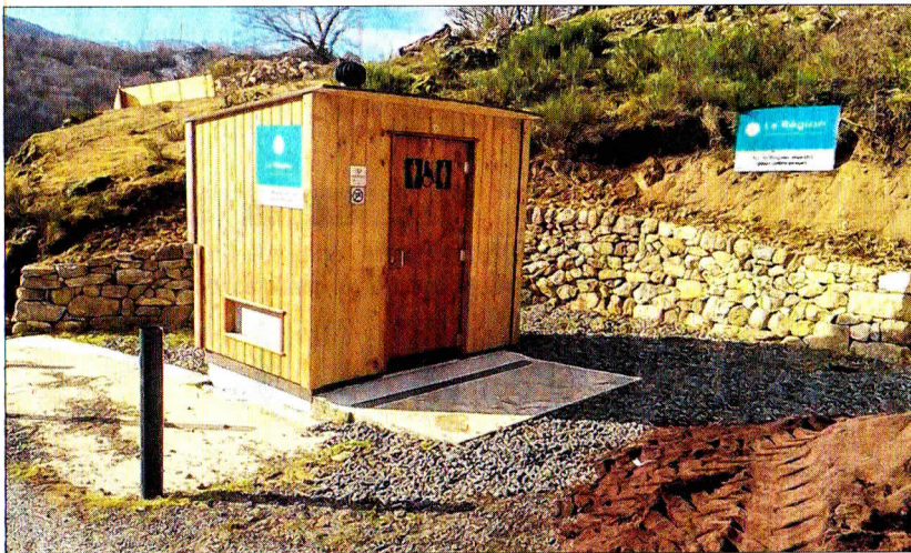
Bâti en pierres locales, le mur s'intègre dans le village.
